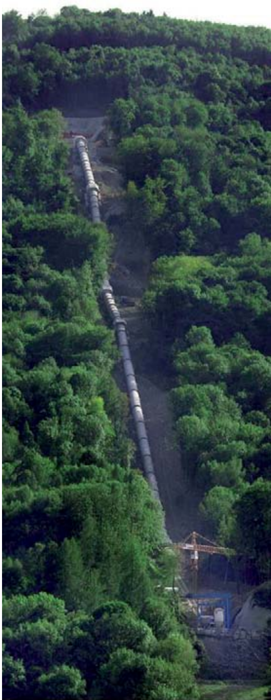
Edina črpalna hidroelektrarna v Sloveniji je Avče na reki Soči. Foto: Soške elektrarne Nova Gorica d.o.o.
