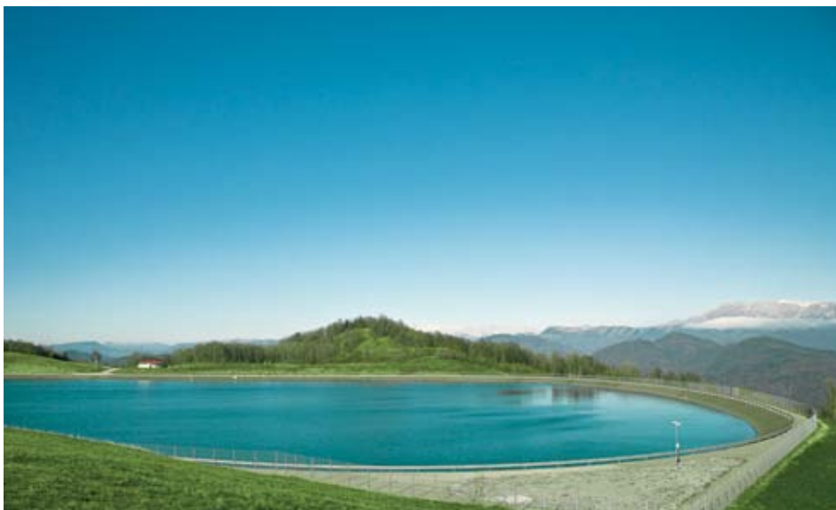
Črpalna hidroelektrarna (ČHE) deluje v dveh režimih: ko je višek elektrike, elektrarna deluje v režimu črpanja - črpa vodo iz nižjega rezervoarja v višjega, pri tem porablja energijo. Ko pa je potrebno proizvajati elektriko pa obratno - voda teče iz višjega rezervoarja v nižjega in pri tem generira elektriko. Zgornji bazen, Kanalski Vrh. Foto: Soške elektrarne Nova Gorica d.o.o.
