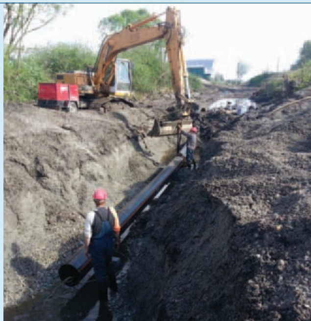
Gradnja preusmeritve izpusta hladilnih vod v Muro
