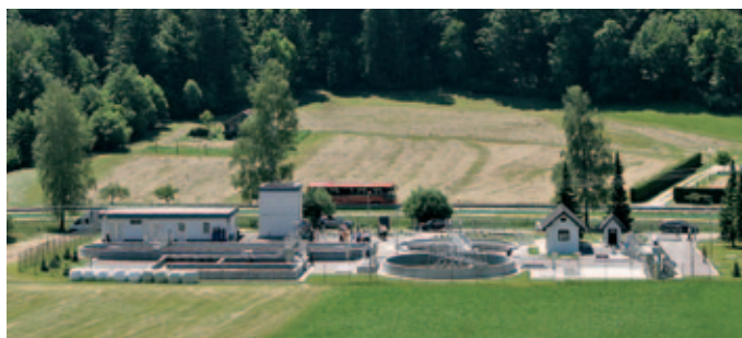
Čistilna naprava Dobrna
