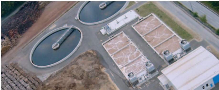
Aerobni del čistilne naprave (BČN)
