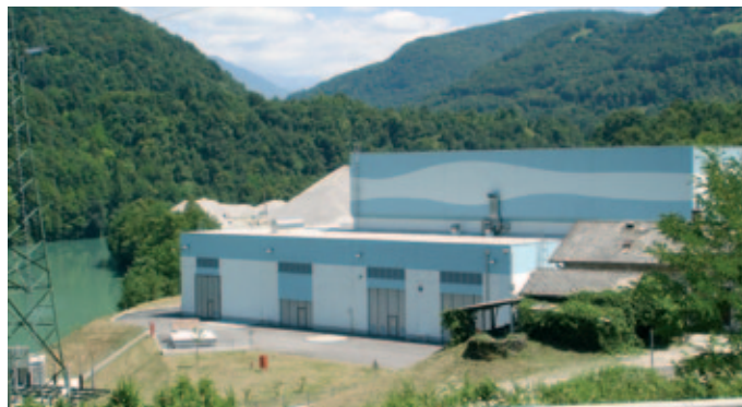
Prva slovenska črpalna hidroelektrarna Avče je del elektroenergetskega sistema Slovenije.
