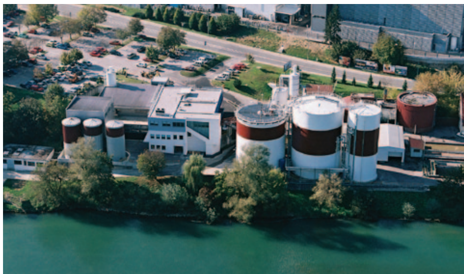
Čistilna naprava v Ločni je bila zgrajena leta 1992, v naslednjih letih se je nadgrajevala in dopolnjevala v skladu z zahtevami zakonodaje na eni in z napredkom na okoljskem področju na drugi strani.
